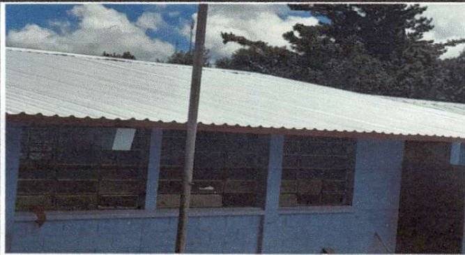
Foto1: Finalización de lámina troquelada aluzinc calibre 26.
