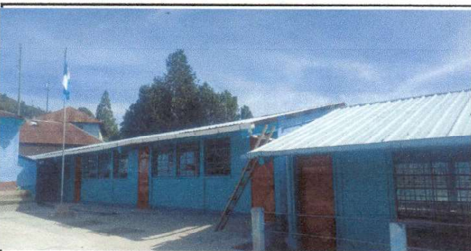
Foto 5: Finalización bajadas de agua.
