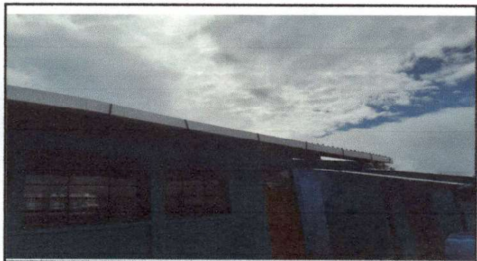
Foto 4: Finalización canales de agua.
