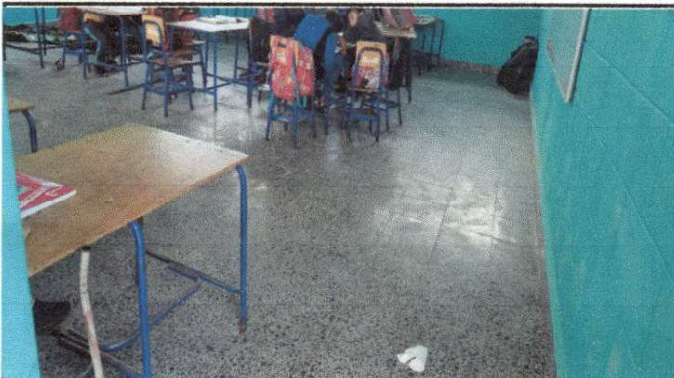
Foto 3: Finalización de piso de granito.
