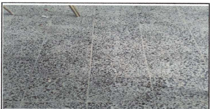
Foto 6: Finalización piso de granito.
